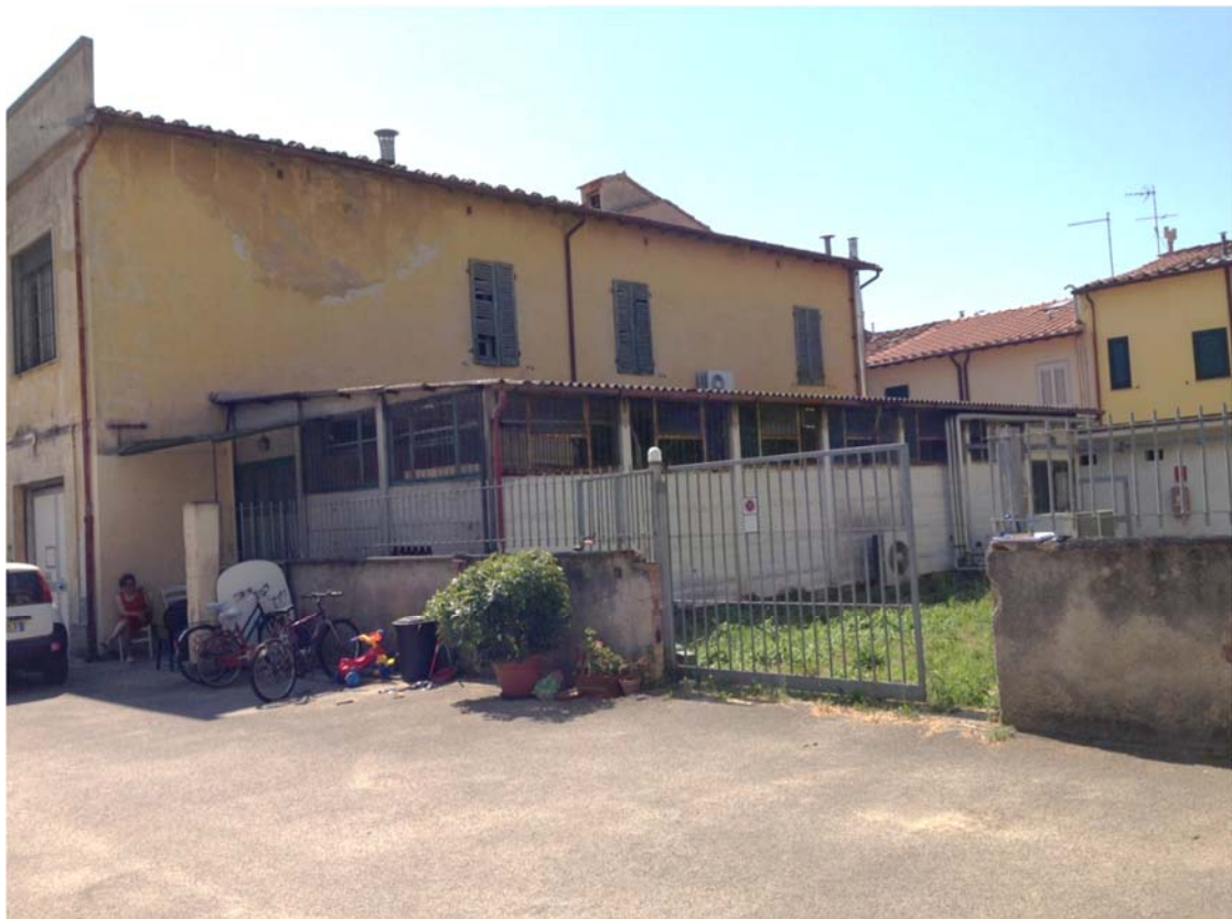
Vista del prospetto Ovest e accesso carrabile al cortile retrostante dalla corte
