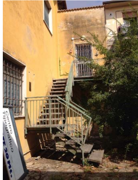
Scala esterna sul prospetto Est
