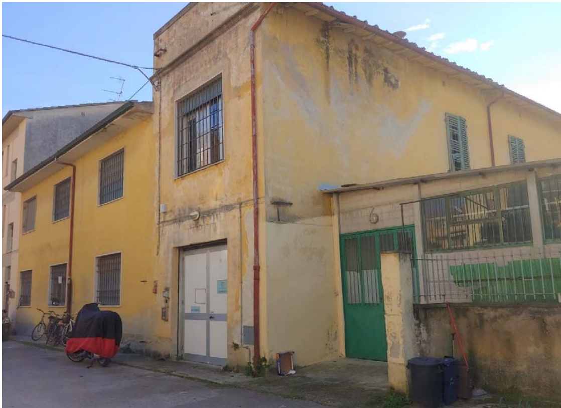
Prospetto Nord sulla corte
