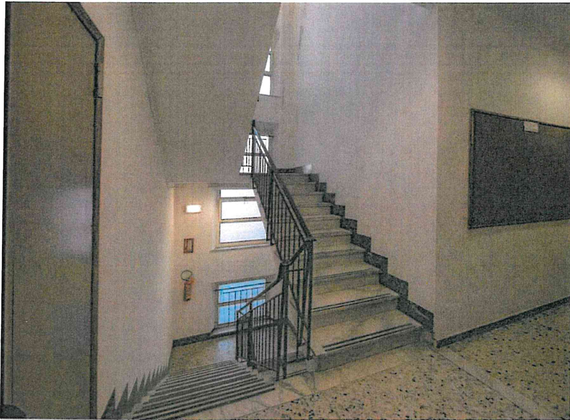
Particolare vano scale condominiale accesso ai piani superiori
