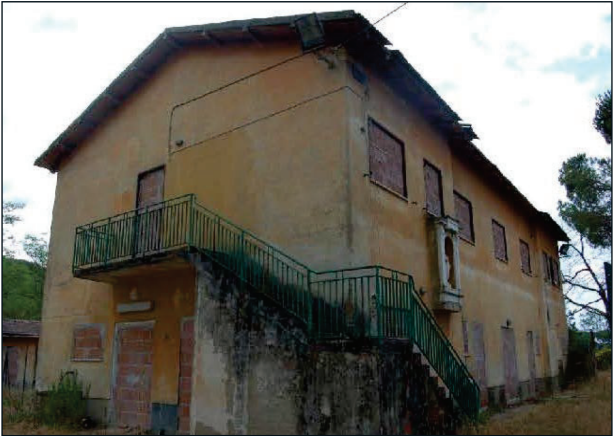
Fabbricato Principale - Prospetto laterale Nord - Scala accesso locali Piano Primo
