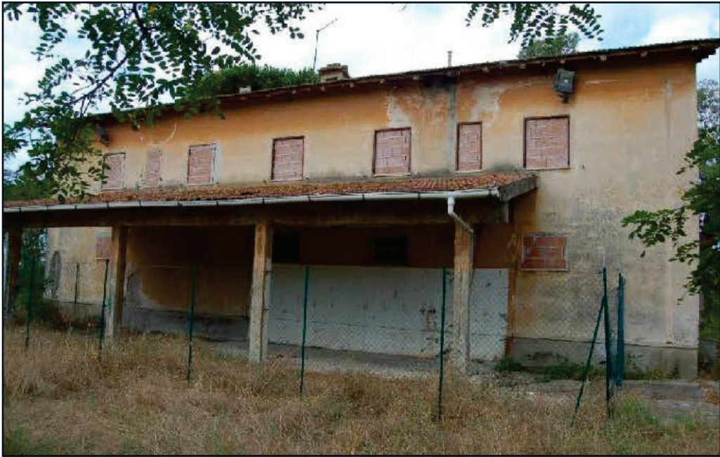
Fabbricato Principale - Prospetto Est - particolare portico
