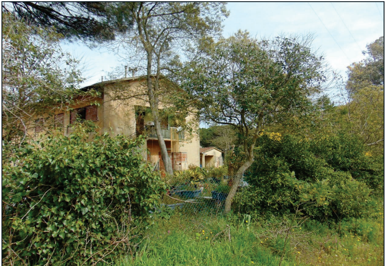
Fabbricato Principale - Prospetto laterale Sud - Accesso appartamento Piano Primo
