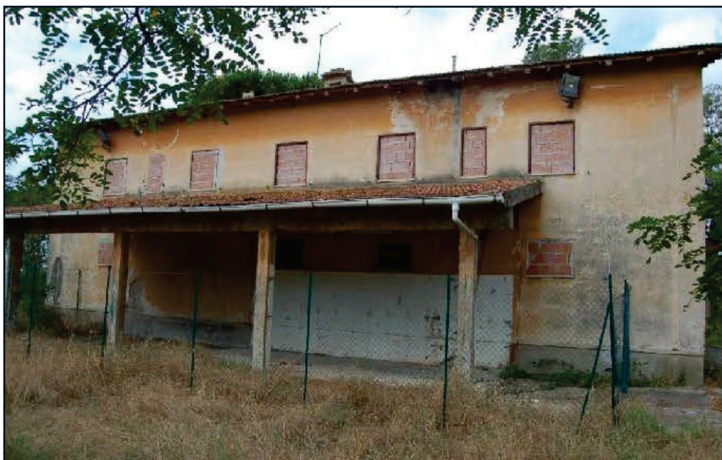
Fabbricato Principale - Prospetto Est - particolare portico
