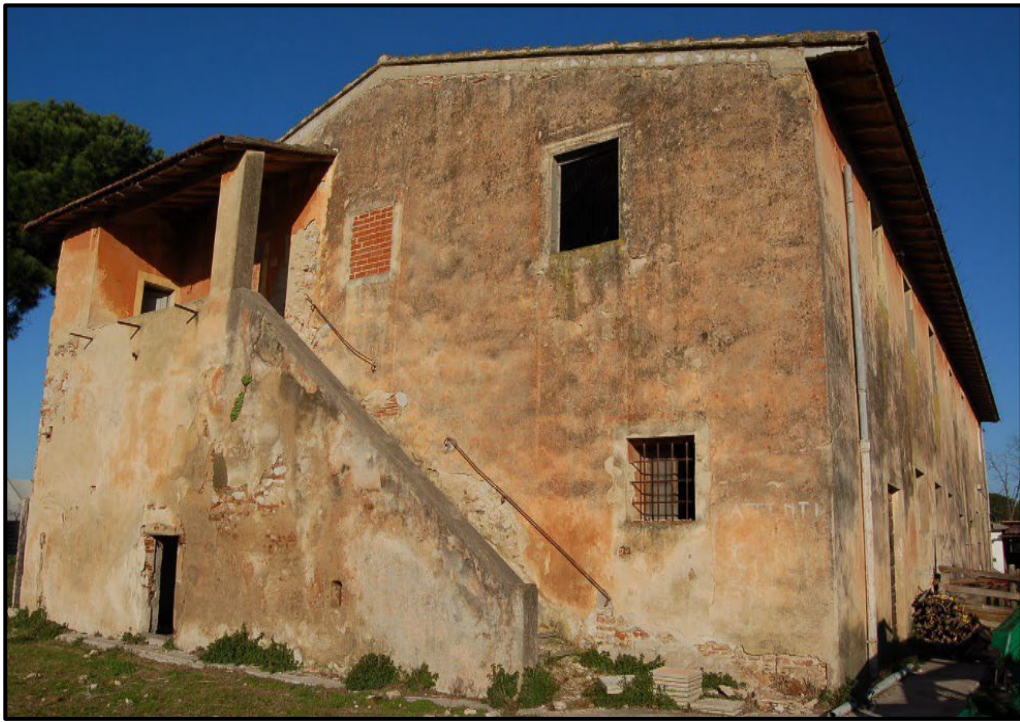
Ingresso altra unità immobiliare
