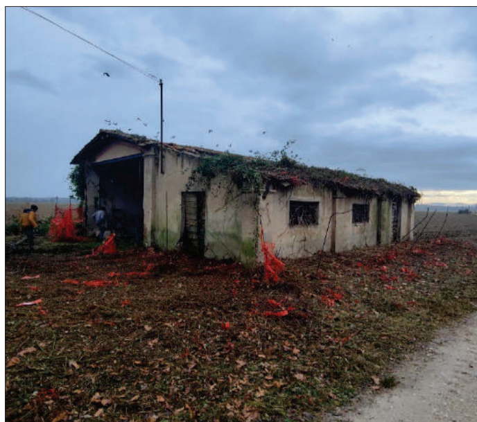
fabbricato annesso n.2 – prospetto nord/ovest
