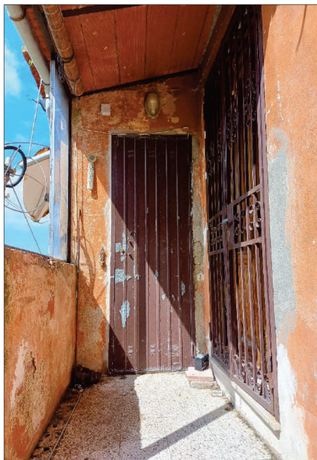
ingresso appartamento p.p. e ripostiglio esterno
