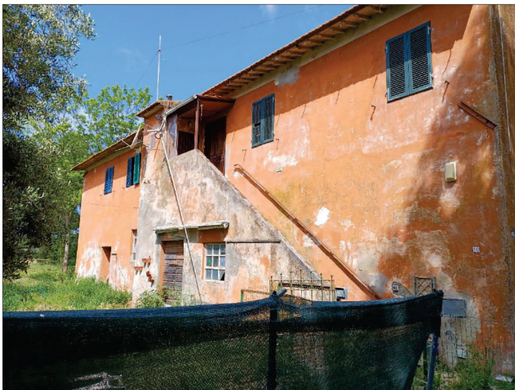
fabbricato principale – prospetto sud
