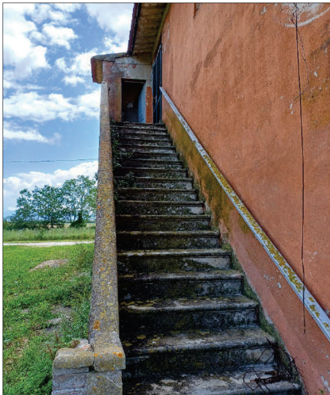
scala accesso laboratori part.108 sub.2
