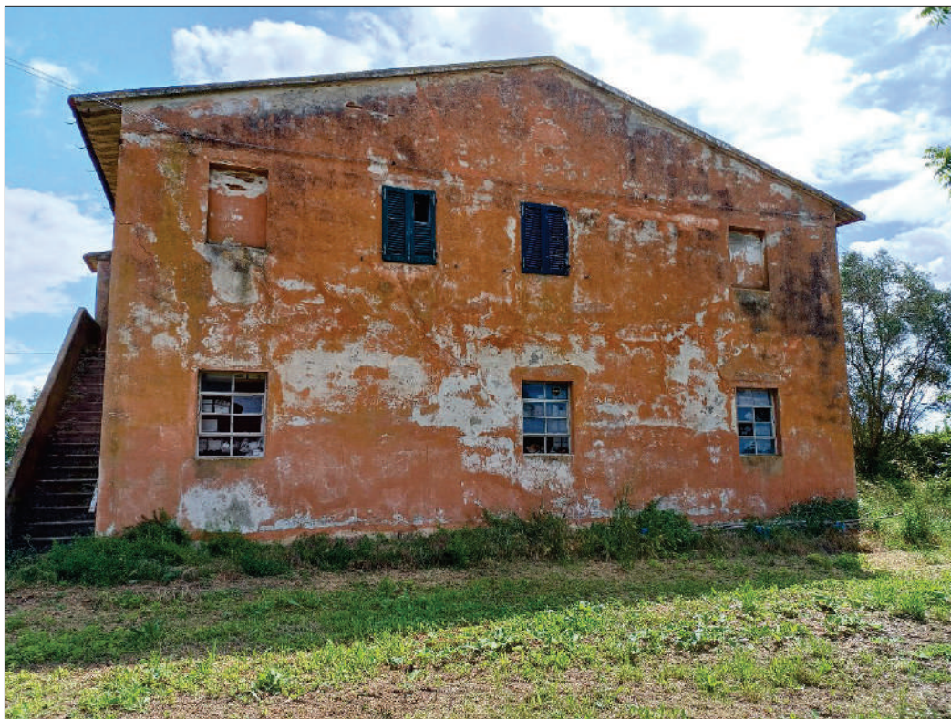
fabbricato principale – prospetto ovest
