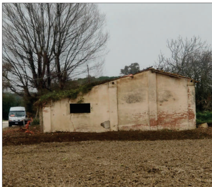
fabbricato annesso n.2 – prospetto sud
