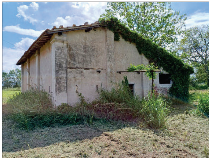
fabbricato annesso n.1 – prospetto ovest
