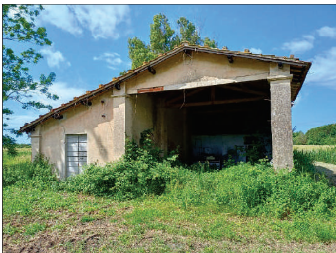
fabbricato annesso n.1 (p.108 sub.4) – prospetto est
