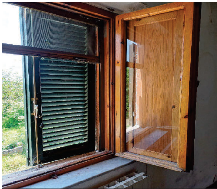
particolare infisso e persiana in legno
