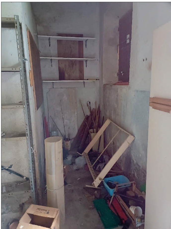
magazzino p.t. (p.108 sub.3)
