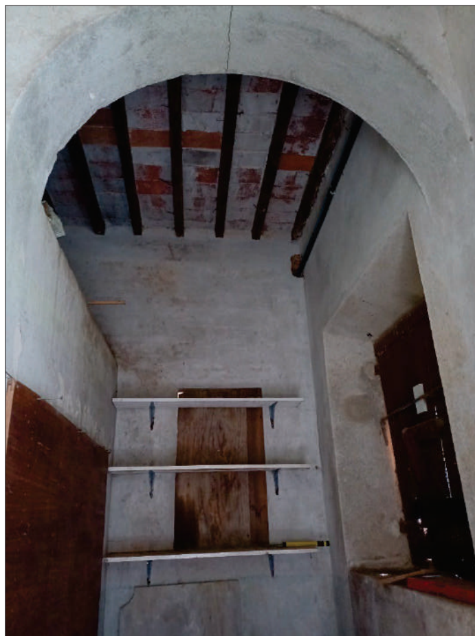
magazzino p.t. (p.108 sub.3)
