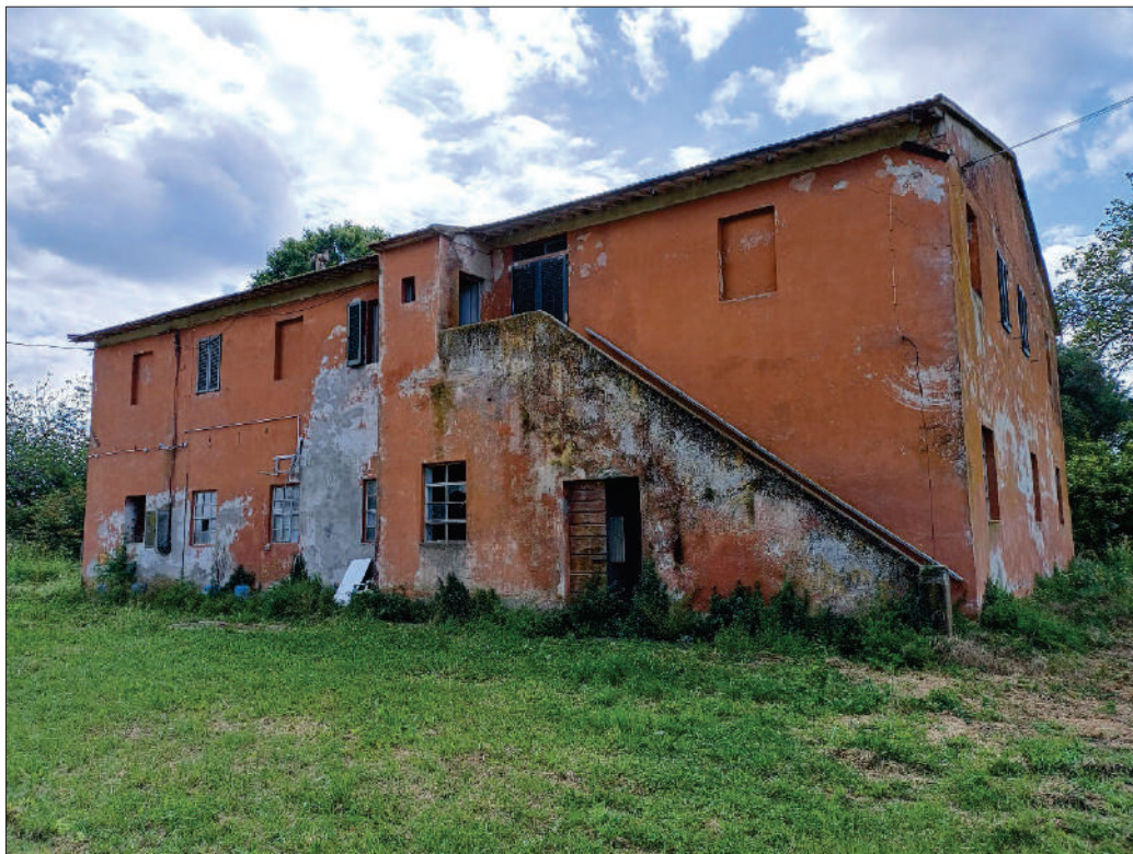
fabbricato principale - prospetto nord
