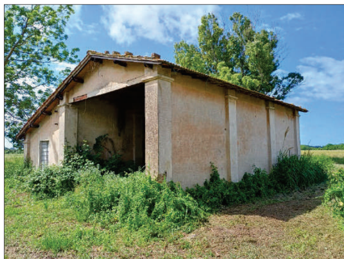
fabbricato annesso n.1 - prospetto nord/est
