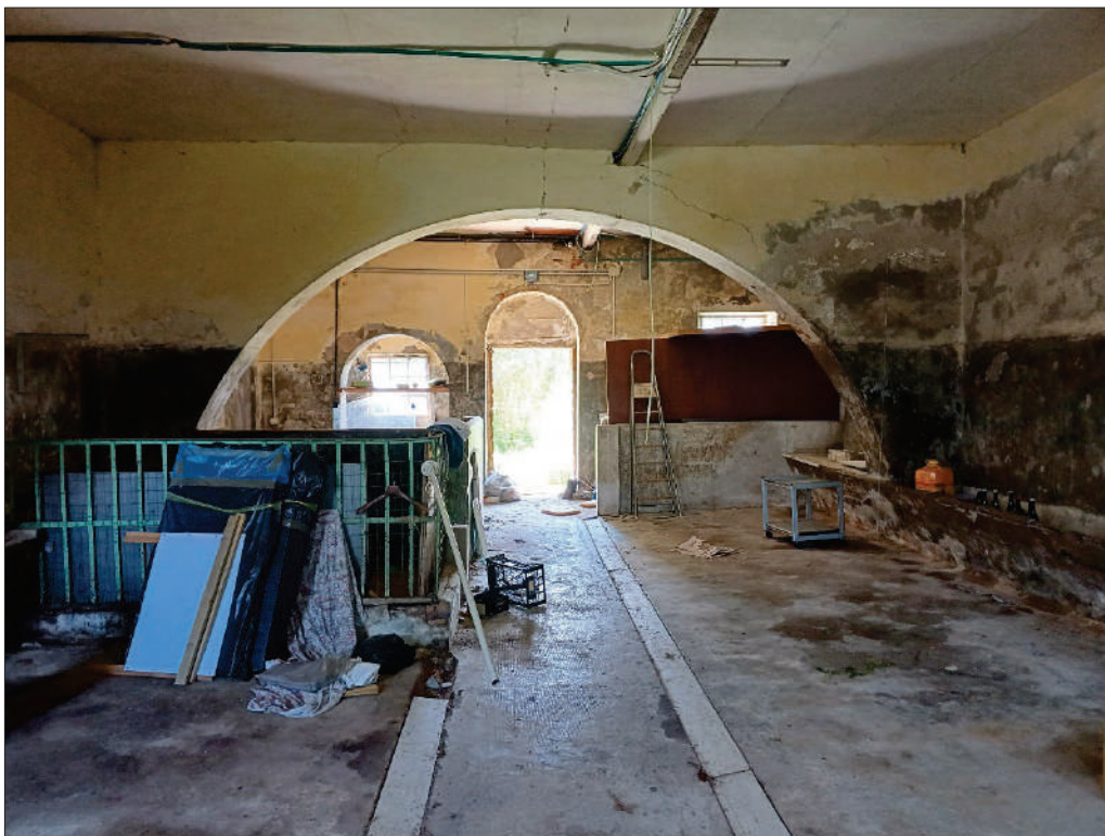
magazzino, ex- stalla p.t. (p.108 sub.2) - interno
