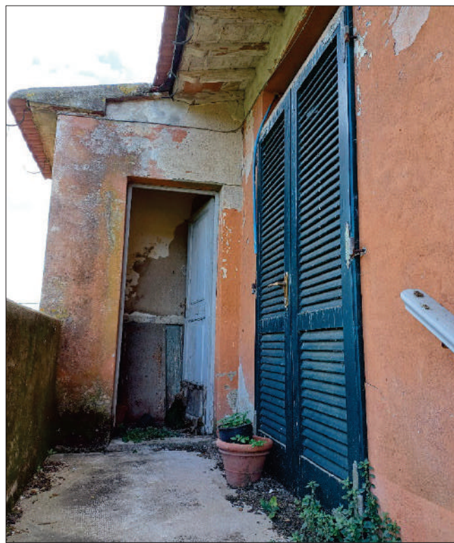
ingresso laboratori P.P.
