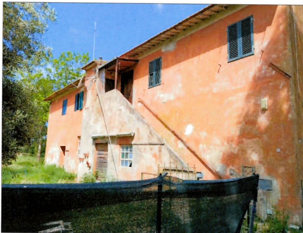
fabbricato principale – prospetto sud
