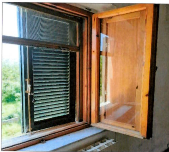
particolare infisso e persiana in legno
