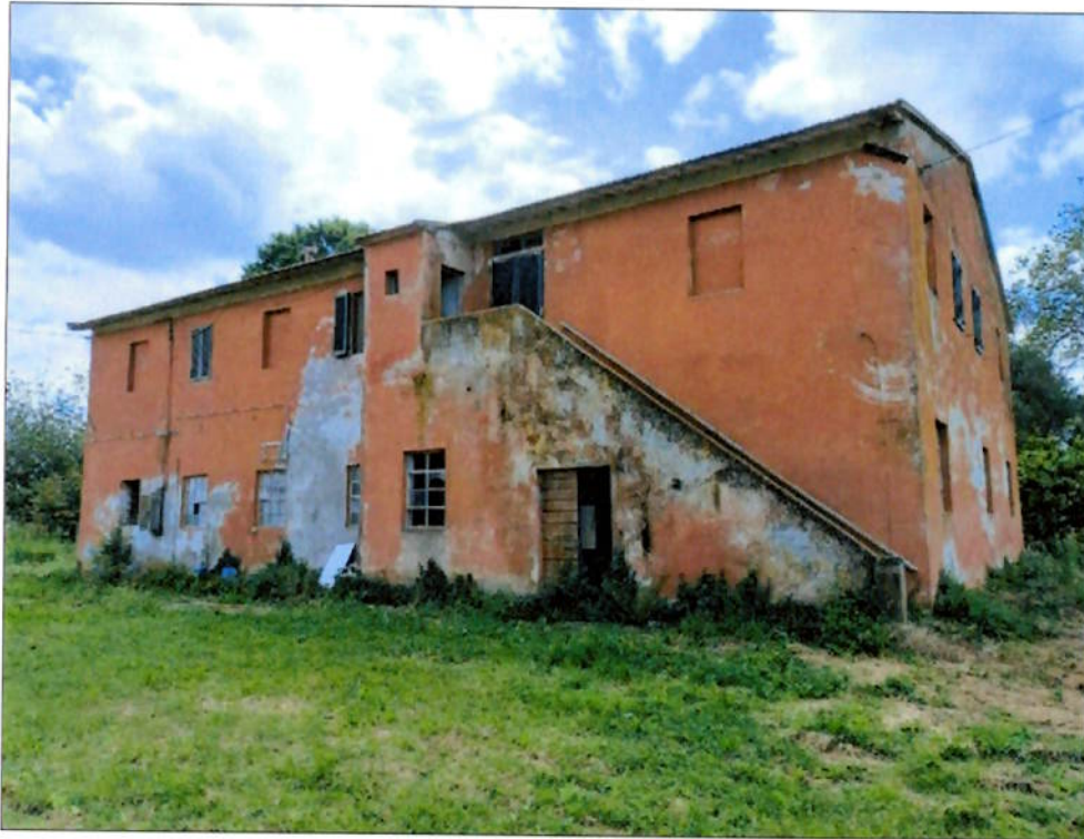
fabbricato principale - prospetto nord
