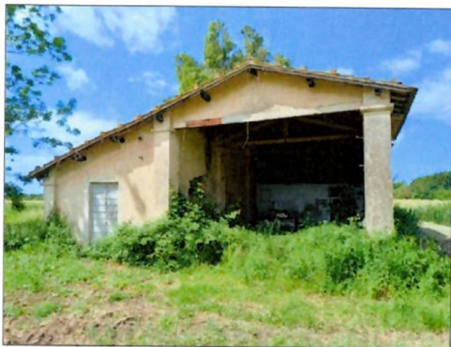
fabbricato annesso n.1 (p.108 sub.4) – prospetto est
