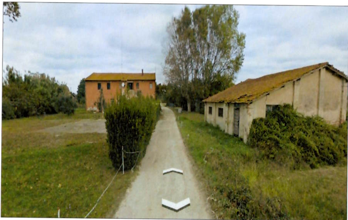
Immagine street view da google earth
