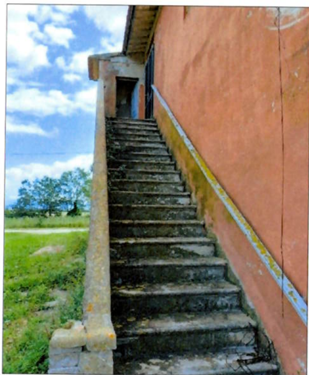
scala accesso laboratori part.108 sub.2
