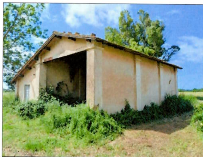
fabbricato annesso n.1 - prospetto nord/est
