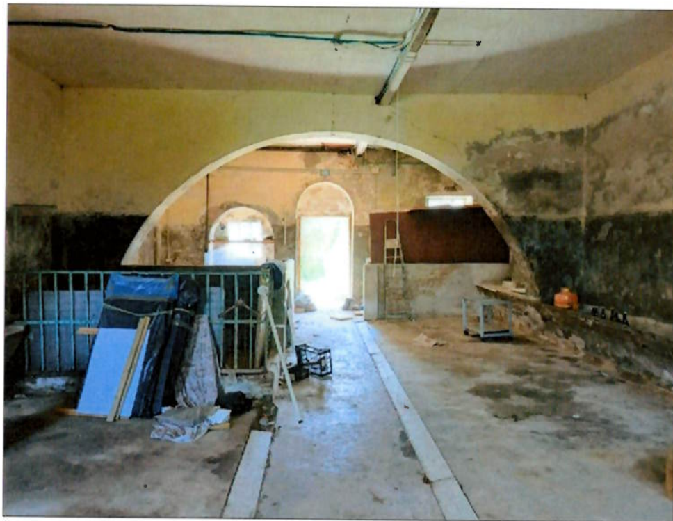
magazzino, ex- stalla p.t. (p.108 sub.2) - interno
