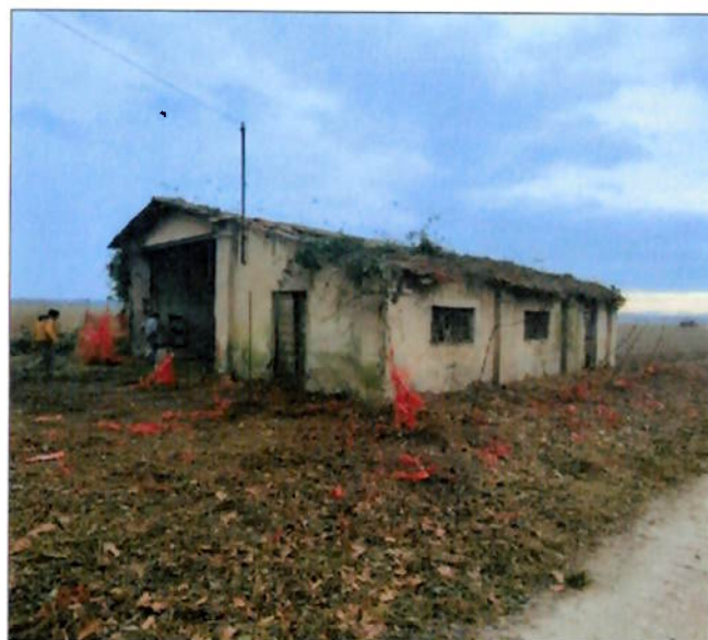
fabbricato annesso n.2 – prospetto nord/ovest
