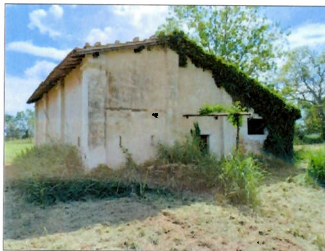
fabbricato annesso n.1 – prospetto ovest
