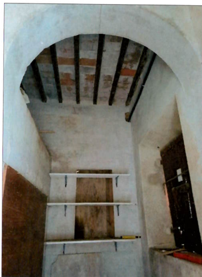
magazzino p.t. (p.108 sub.3)
