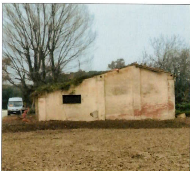
fabbricato annesso n.2 – prospetto sud
