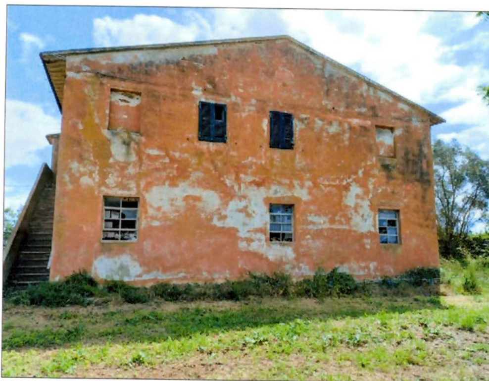
fabbricato principale – prospetto ovest
