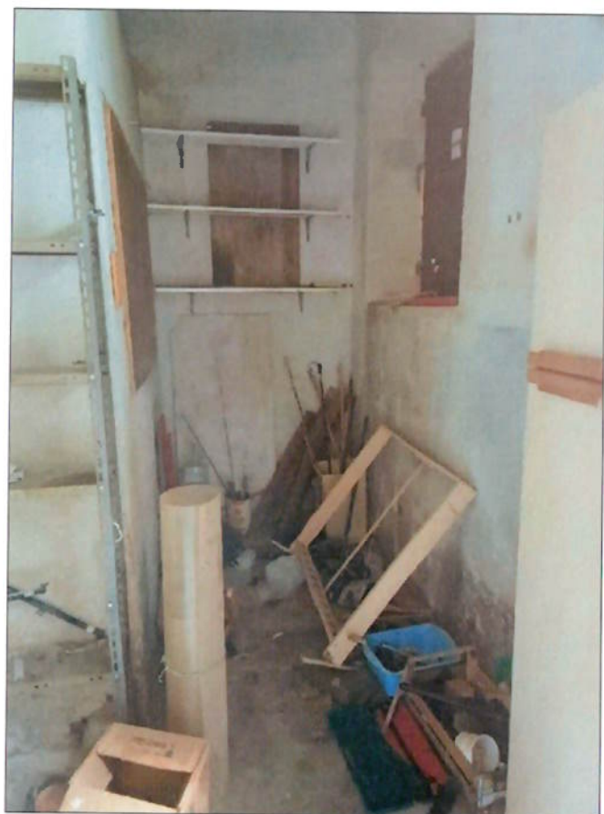
magazzino p.t. (p.108 sub.3)
