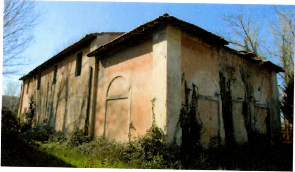
Sub. 4 - Vista Prospetti Nord - Est
