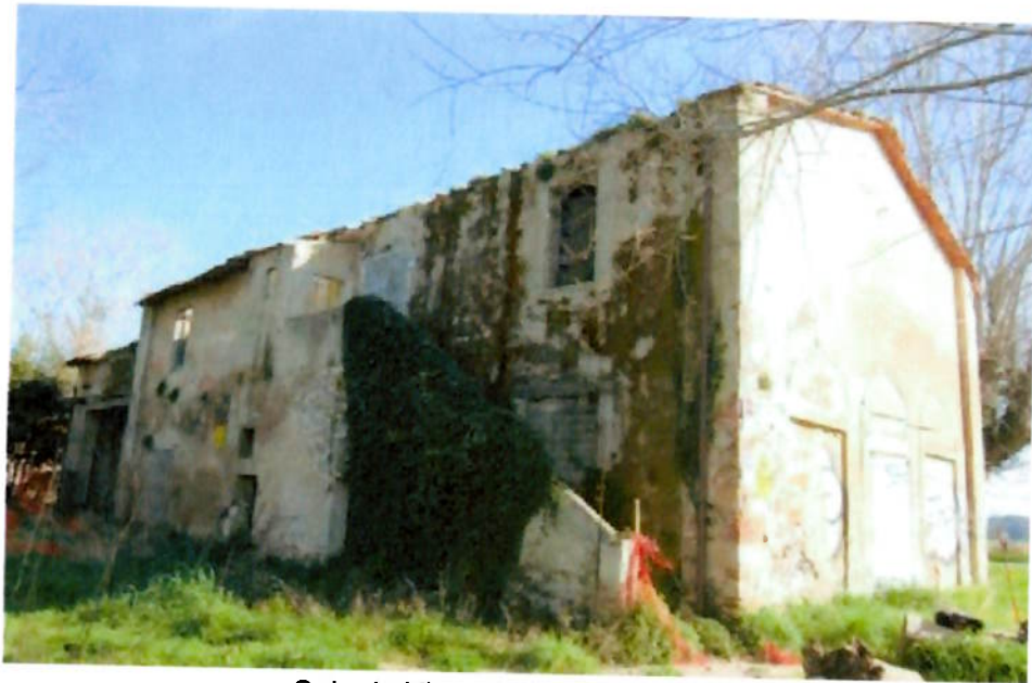
Sub. 4 - Vista Prospetti Ovest - Sud
