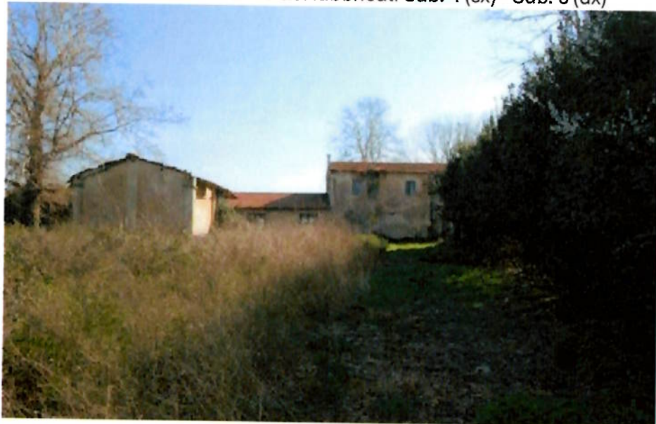
Vista dall'interno resede dei fabbricati Sub. 5 (sx) - Sub. 8 (sfondo sx) - Sub. 7 (sfondo dx)
