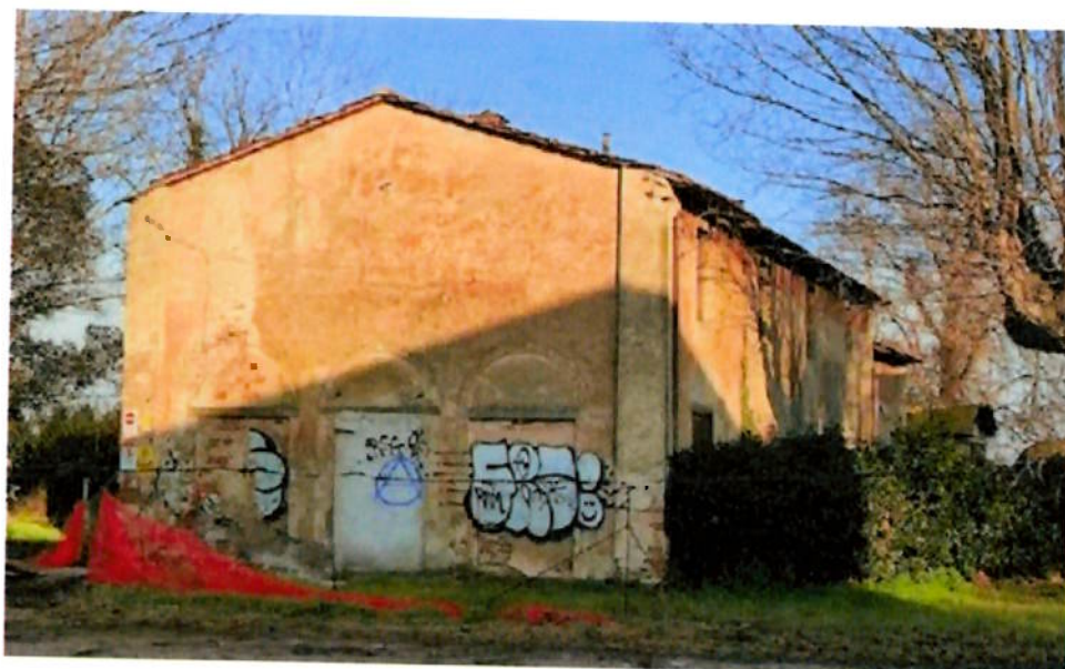
Sub. 4 - Vista dalla Via della Bigattiera Prospetti Sud - Est
