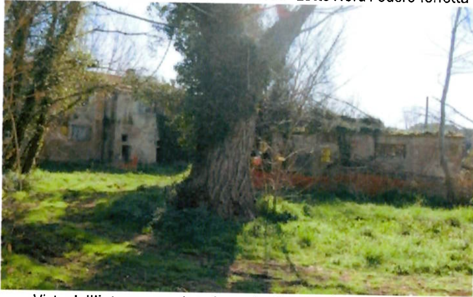
Vista dall'interno resede dei fabbricati Sub. 4 (sx) - Sub. 6 (dx)
