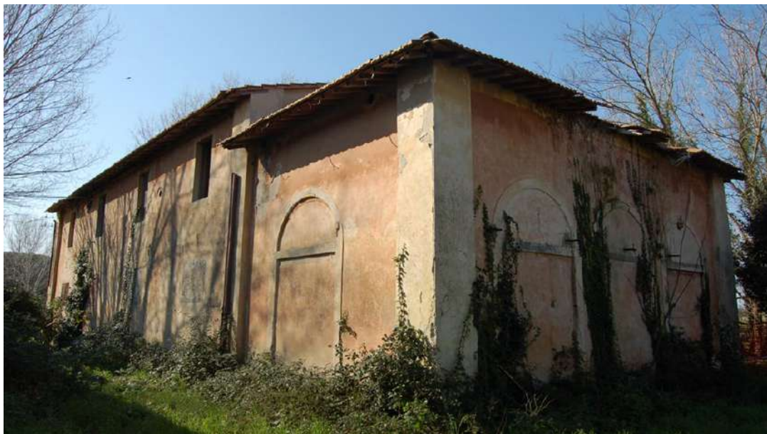
Sub. 4 - Vista Prospetti Nord - Est
