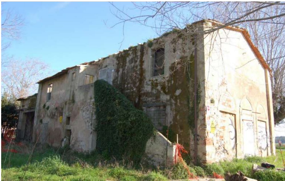
Sub. 4 - Vista Prospetti Ovest - Sud
