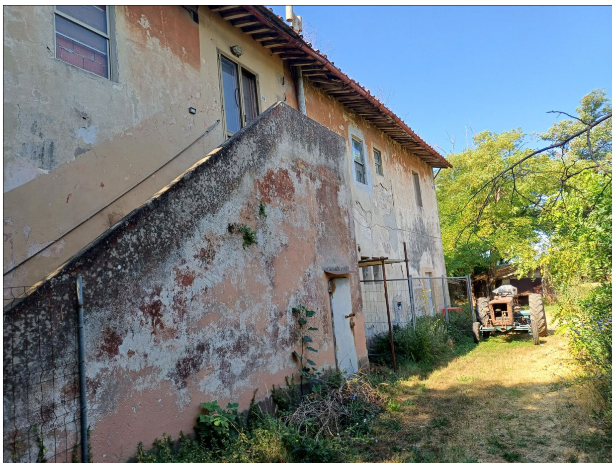
Fabbricato principale – prospetto nord
