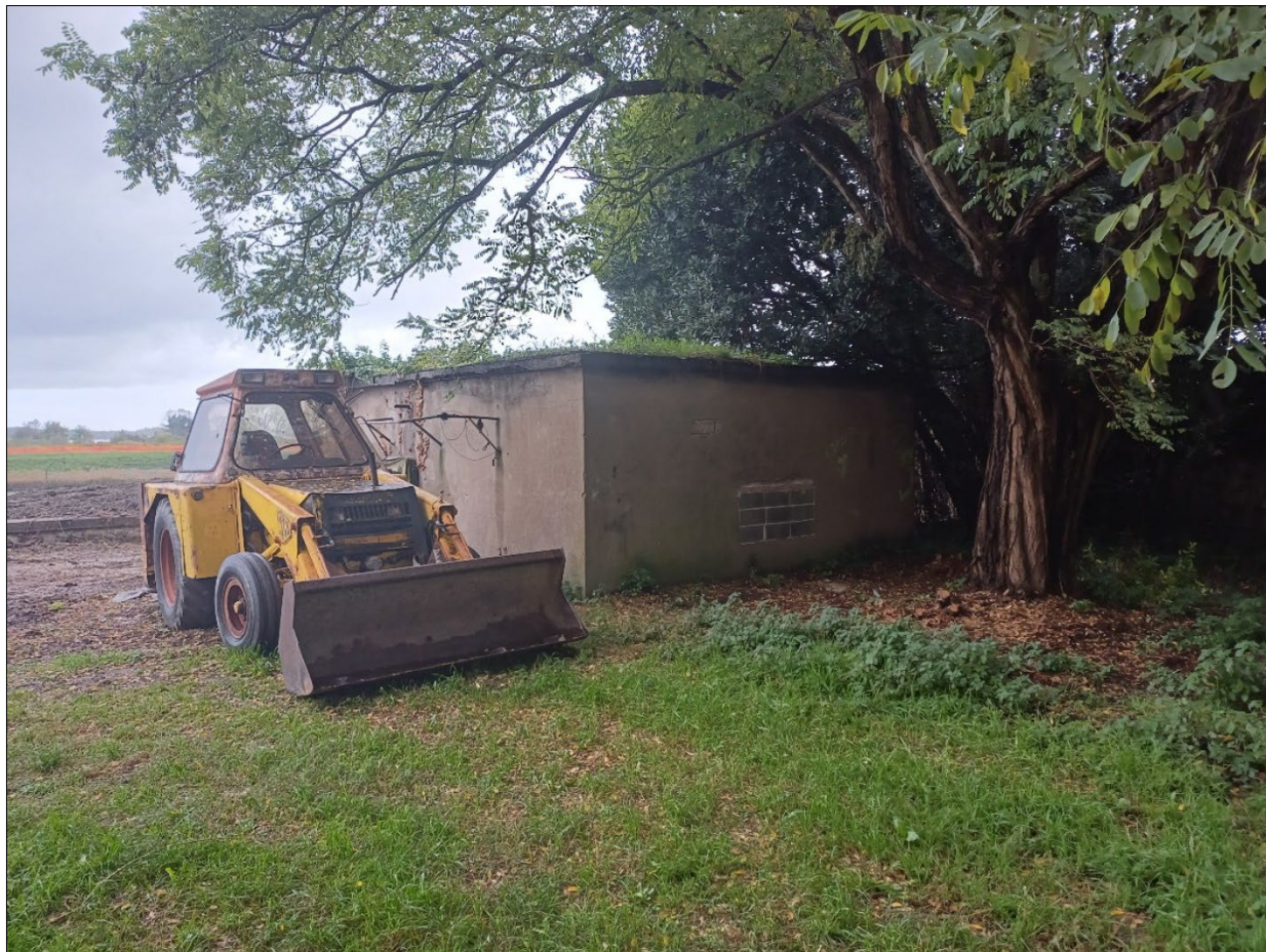
Locale tecnico (in disuso)
