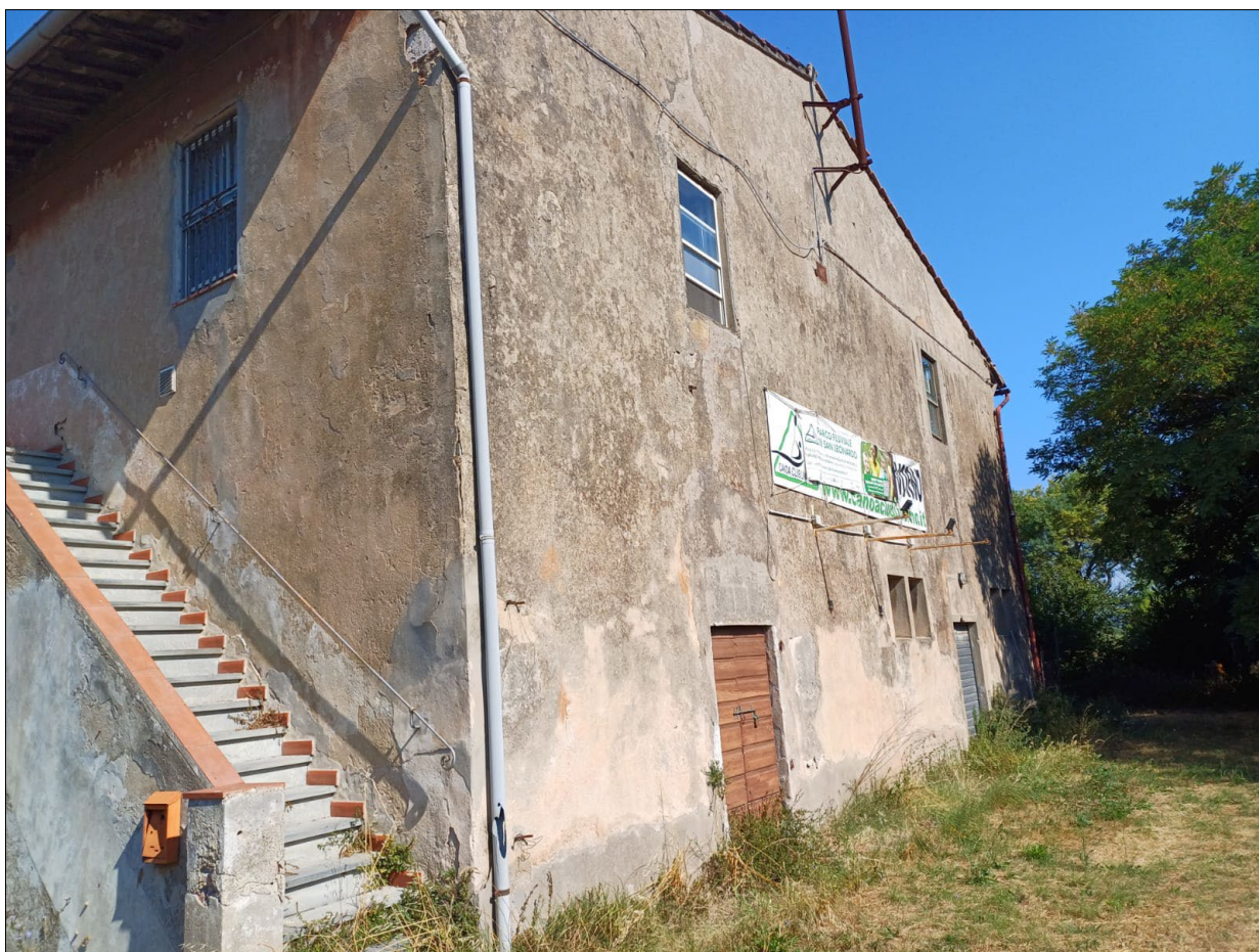
fabbricato principale – prospetto est
