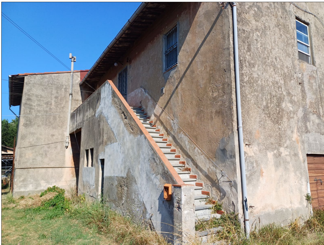
fabbricato principale – prospetto sud
