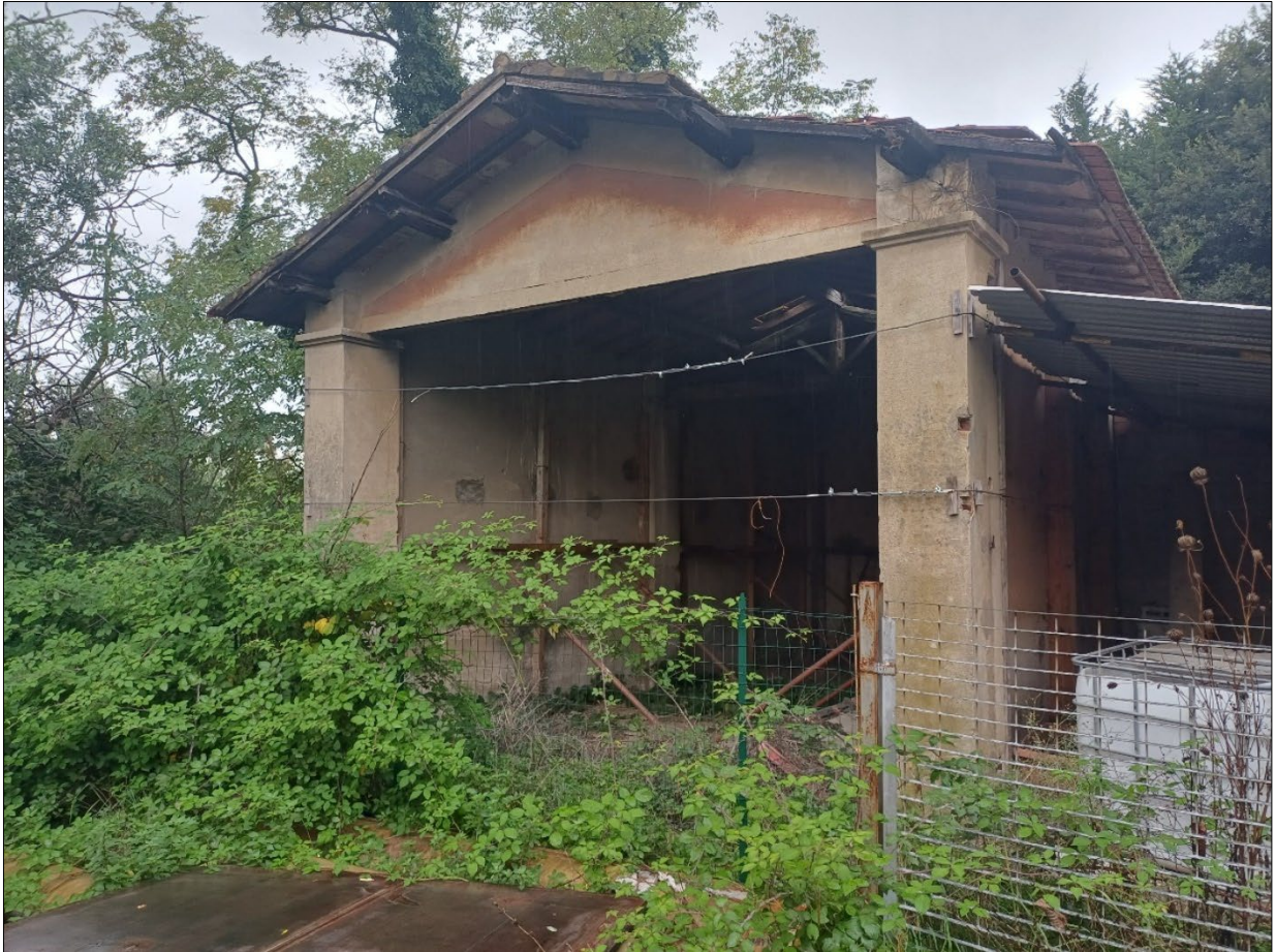
Fabbricato annesso n.1
