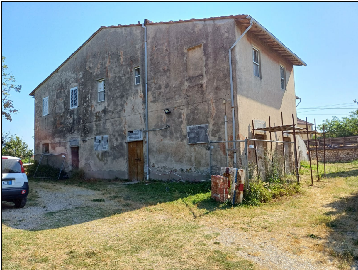
Fabbricato principale - prospetto ovest
