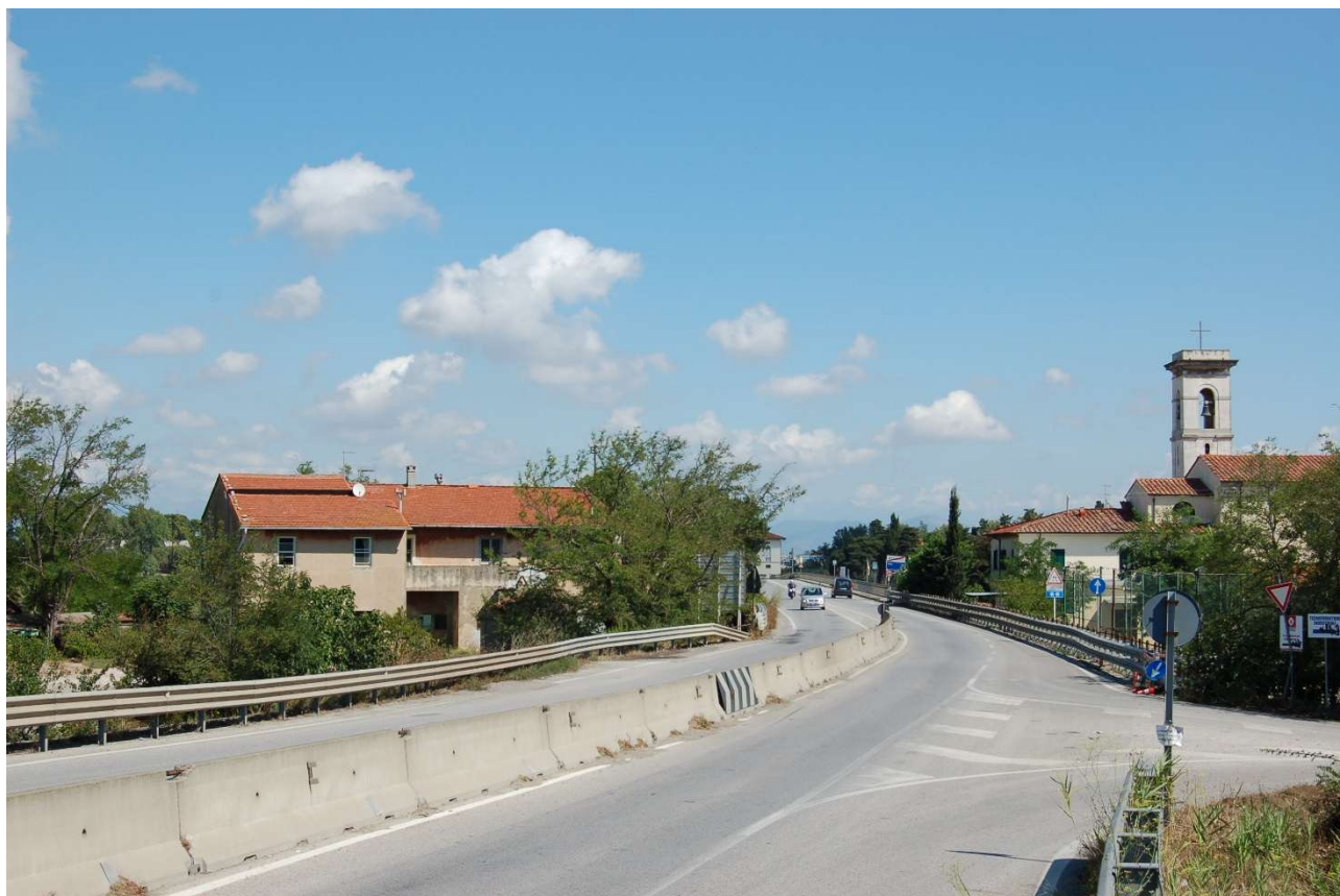
Vista del fabbricato principale dalla Via Statale Aurelia – (sulla sinistra prospetto sud)
