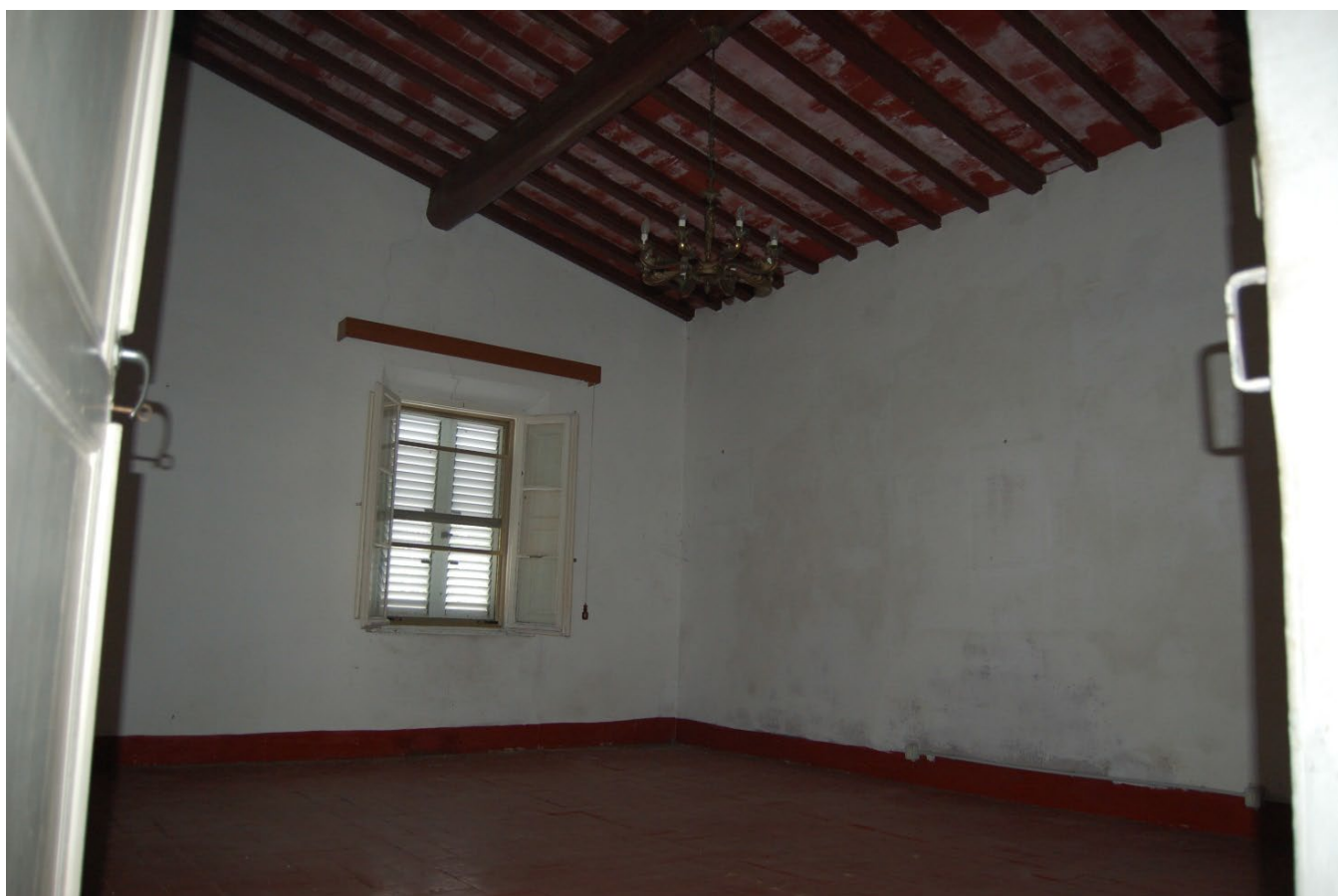
Camere da letto appartamento Sub. 1 - particolare tipologia pavimento e soffitto
