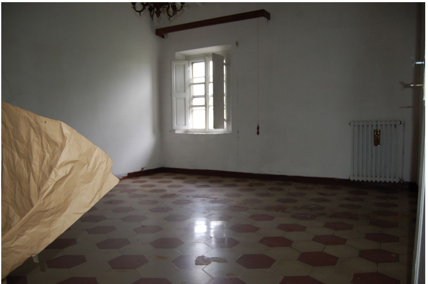
Camere da letto appartamento Sub. 1 - particolare tipologia pavimento
